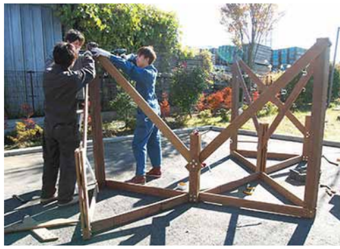
組立作業風景
